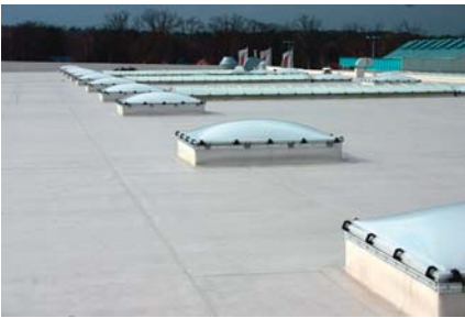
Rund 45.000 m 2 Dachfläche aus Sandwichelementen auf dem Einkaufszentrum wurden in kürzester Zeit mit einer FPO-Kunststoffdachbahn neu abgedichtet.
