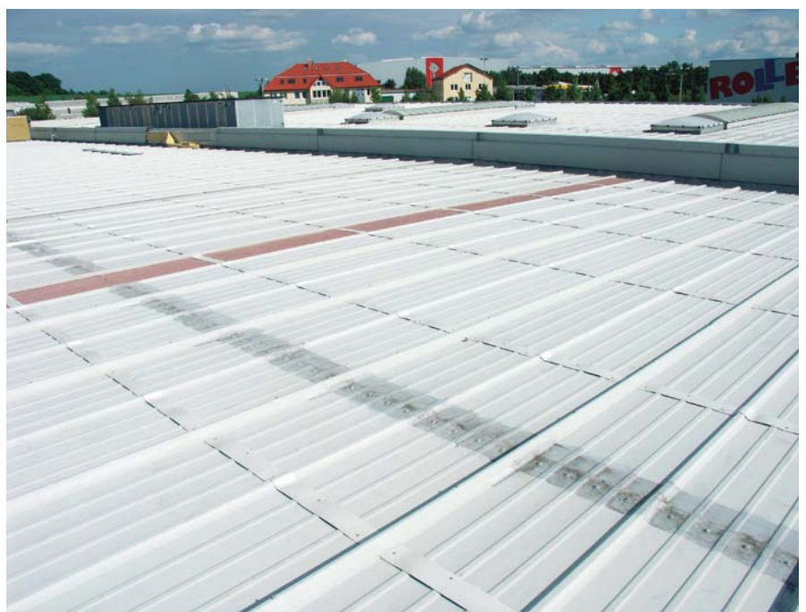
Die dunklere Färbung zeigt die mit Flüssigkunststoffen behandelten Querstöße in den Sandwichelementen an. Darüber und darunter sind bereits die Verstärkungstreifen montiert.
