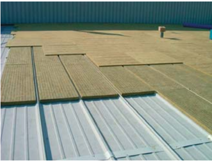
Zwei Lagen Mineralwolle egalisieren die Profilierung der Sandwichelemente und bilden die stabile und glatte Unterlage für die neue Abdichtung.
