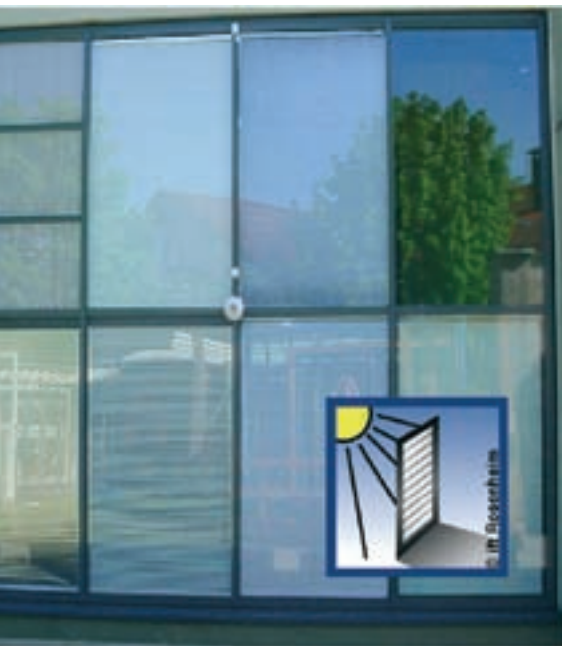
Langzeitprüfung innovativer Sonnenschutz-einrichtungen am ift Rosenheim
