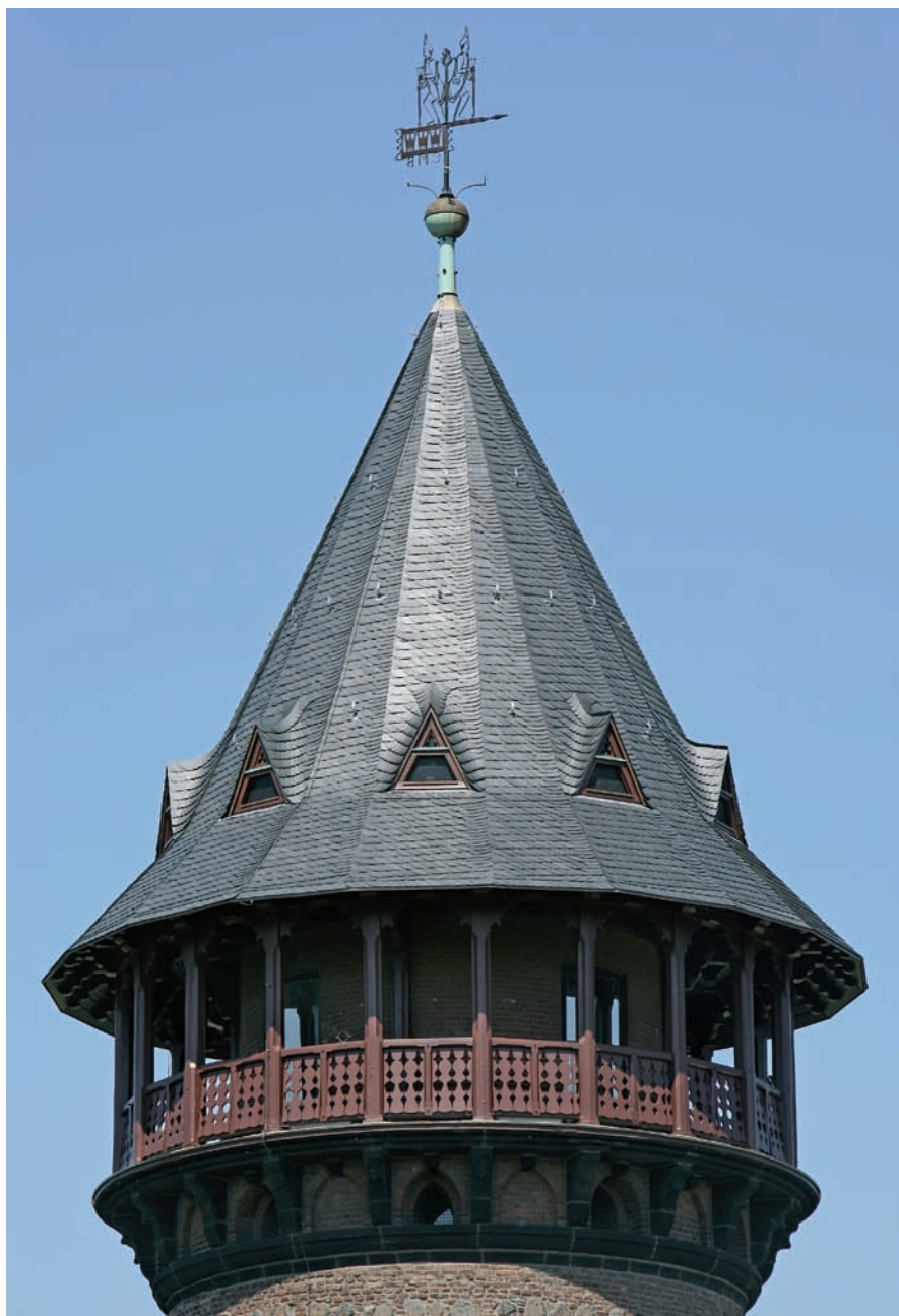
Der Turmhelm ist ein Zwanzigeck. Die Aufschieblinge im unteren Sechstel der Dachfläche verleihen dem hohen Dach eine gewisse Eleganz und erheben sich schützend über dem Turmwehrgang.
