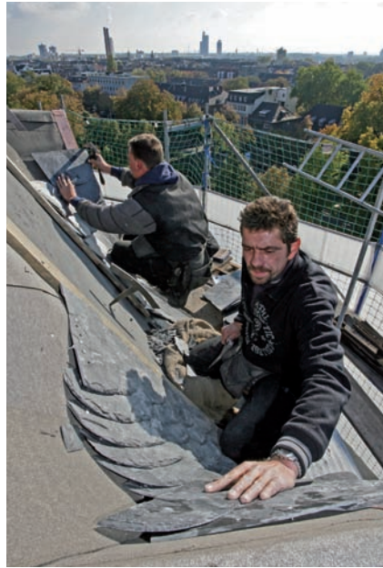
Handwerk und Kunst: Schieferdeckung am Turmhelm der Ulrepforte in Köln.
