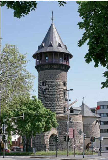
Die Ulrepforte in Köln wurde 1220 errichtet und erhielt 1885 den prägenden Turmhelm mit Schieferbekleidung.
