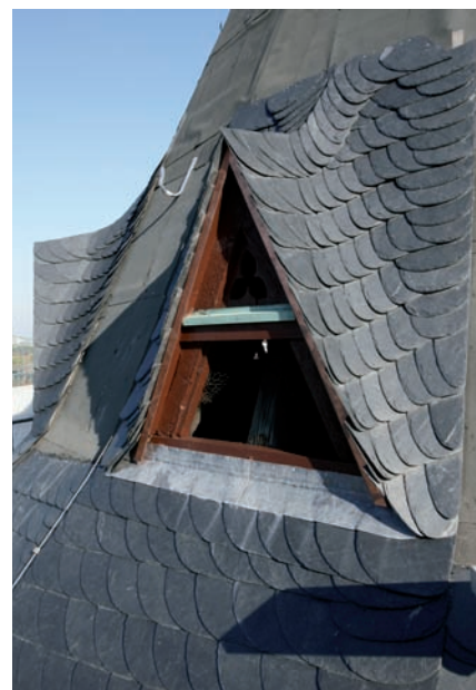
Die Deckung der Spitzgaube beginnt am Spiegel mit einem eingebundenen Anfangort. Die Rechtsdeckung aus Kehlsteinen mit rundem Rücken geht, wegen der sehr engen Situation in den unteren drei Gebinden, direkt in den Grat über. Ab dem vierten Gebinde schließt die Deckung am Grat mit einem Doppelort ab.
